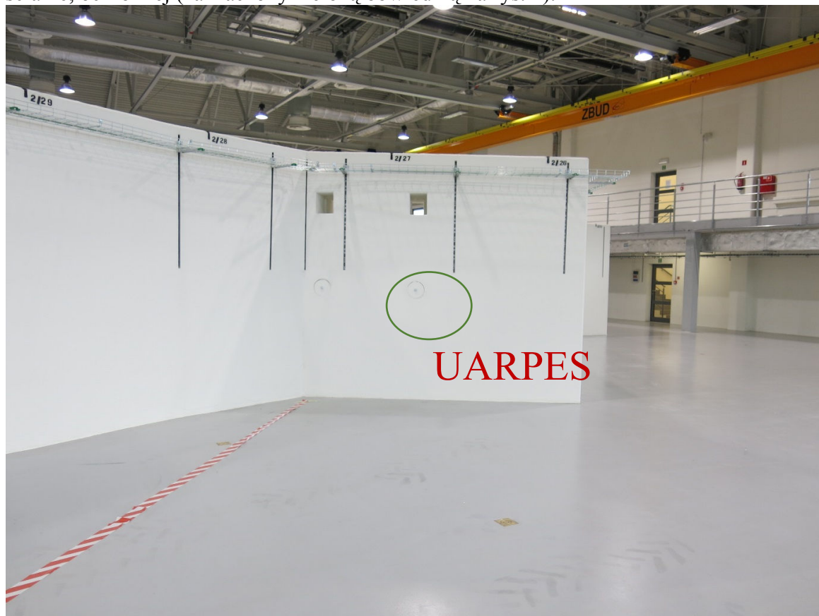
Rysunek 1. Hala eksperymetalna w Solaris, widok na ścianę ochronną. Zielona obwiednia wskazuje na otwór dla UARPES. Otwór po lewej stronie, wykorzystany będzie dla linii pomiarowej z przylegająca klatką.
